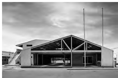
中庭側からの外観：屋根は筑波山のイメージ
