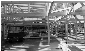
柱や梁の構造部分が組み上がり、木造建築の文化である棟上げ式を生徒を集めて行った。
